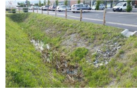
Exemple de dispositif de gestion des eaux pluviales, ici un fossé.
