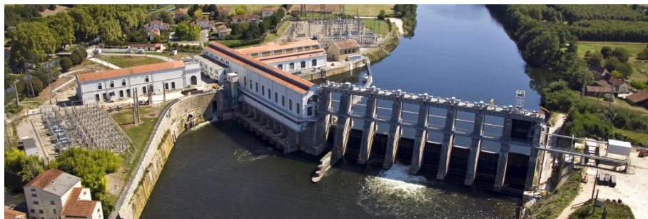
Barrage hydroélectrique de Tuilière sur la Dordogne.
