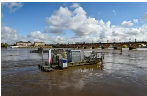
Essai d'une hydrolienne, Bordeaux.
