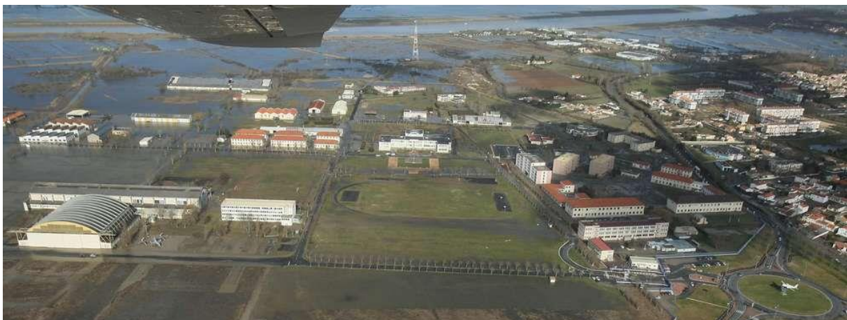
Photo 16 : Submersion marine sur la commune de Rochefort par suite de la tempête Xynthia, en 2010. Source : sudouest.fr, D. JULLIAN.
