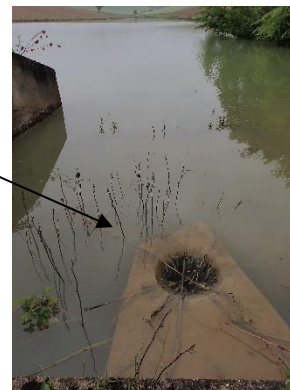
Photo 3 : Exemple de déversoir
