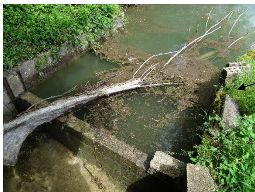
Photo 2 : Exemple de déversoir
